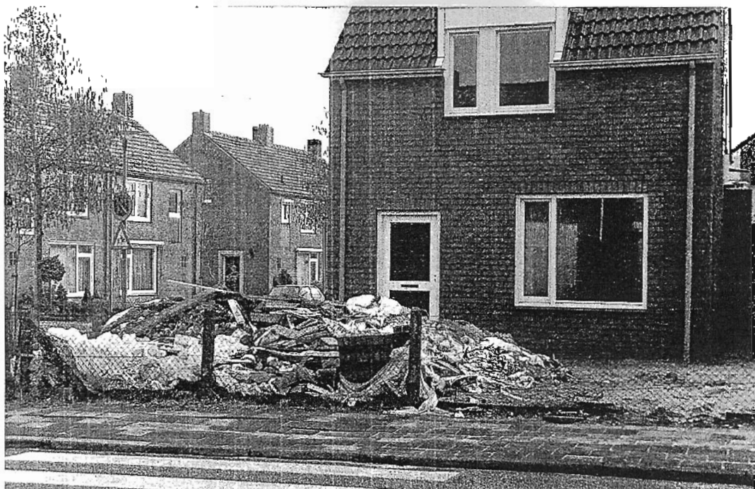
Bij dit kleine bouwproject werd alle afval op een hoop gedeponeerd. Het scheiden ervan in diverse fracties is duur en bijna onmogelijk.
