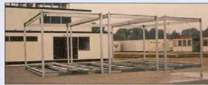
Stalen draagconstructie van een modulaire module.
