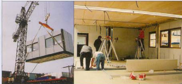
Boven: De opeenvolgende productieprocessen bij modulair bouwen. Links: Aanvoeren en monteren van modules op de bouwplaats. Rechts: Installatiewerk in de module op een assemblagelijijn.
