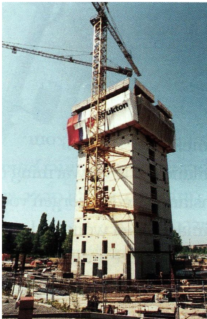
Rembrandtoren Amsterdam: Afgeschermdde klimbekisting
